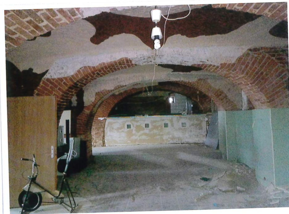
Fot. 10. Piwnice w skrzydle wschodnim.
