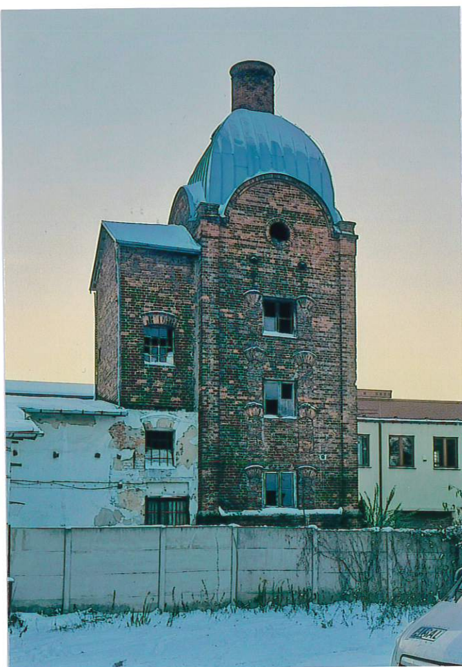
Fot. 2. Wieża słodowa – widok od północy.
