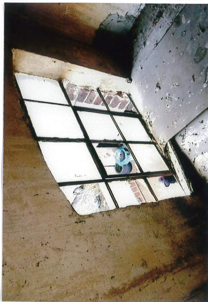
Fot. 12. Okno w wieży słodowej.
