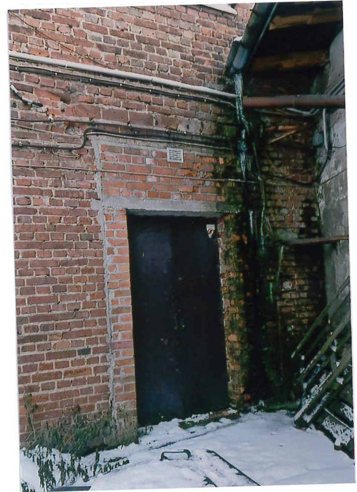
Fot. 6. Wejście od podwórza do skrzydła wschodniego (przy styku ze skrzydłem południowym).
