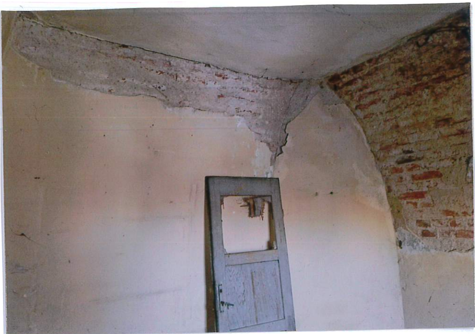
Fot. 14. Ostatnie piętro wieży słodowej.
