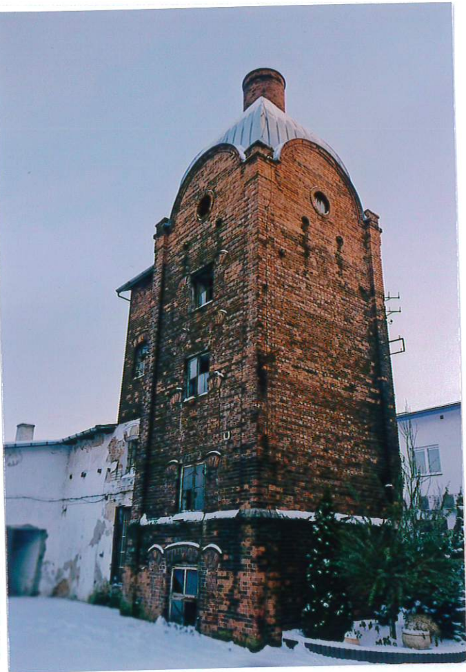
Fot. 4. Wieża słodowa, widok od południowego-zachodu.
