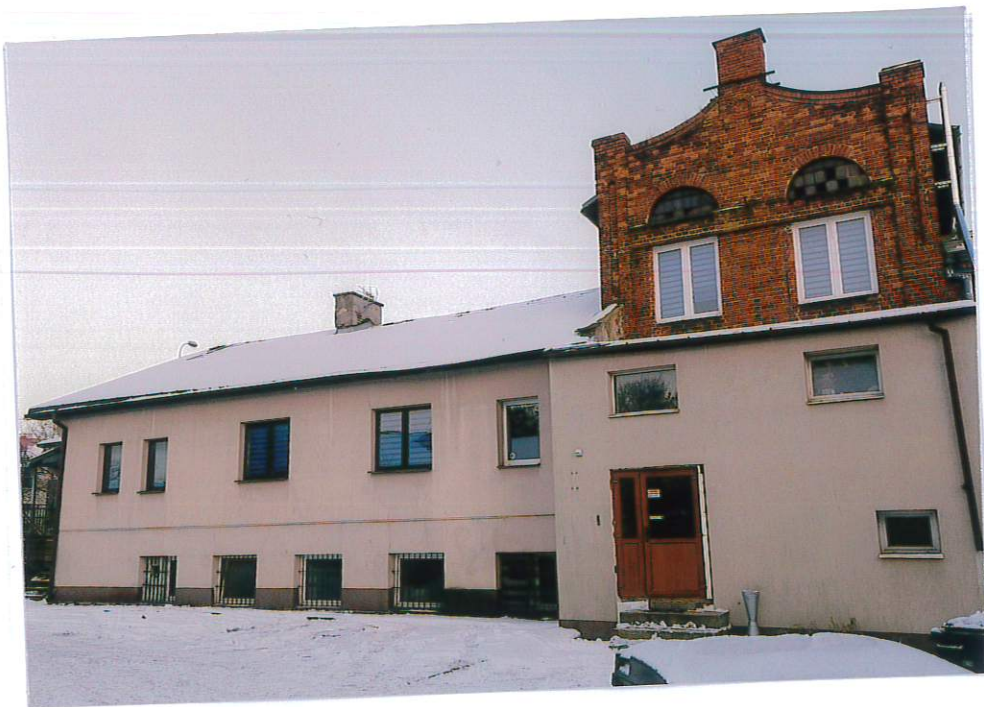
Fot. 7. Skrzydło wschodnie, widok od podwórza (część południowa).
