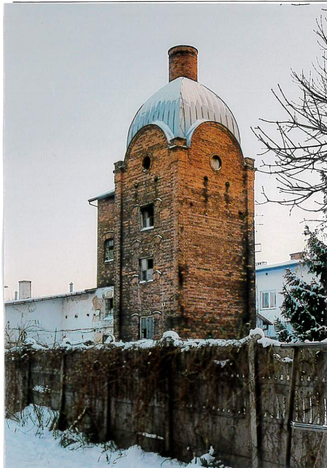
Fot. 1. Wieża słodowa – widok od strony południowo-zachodniej.
