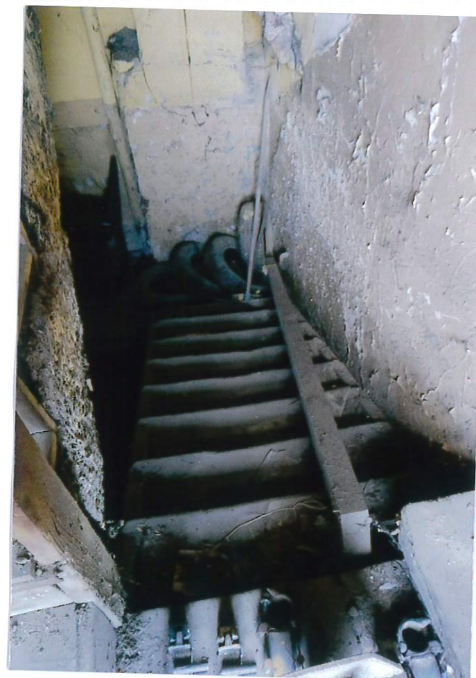
Fot. 13. Schody w wieży słodowej.
