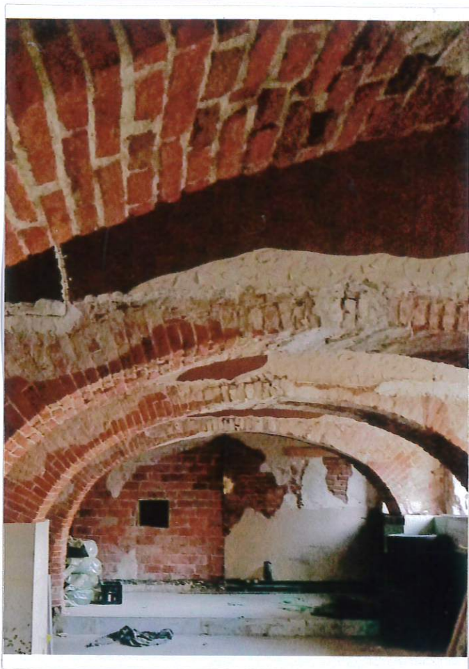
Fot. 11. Piwnice pod skrzydłem wschodnim, od strony północnej.
